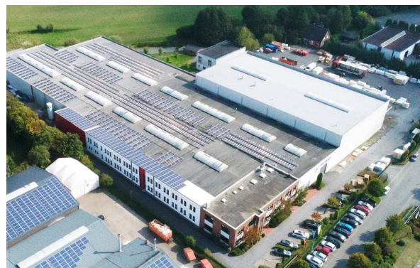
Firmenzentrale und Fertigung mit ca. 12.000 m 2 Produktionsfläche
