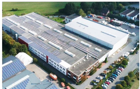
Firmenzentrale und Fertigung mit ca. 12.000 m 2 Produktionsfläche
