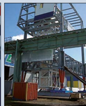
Probeaufbau in Bremerhaven
