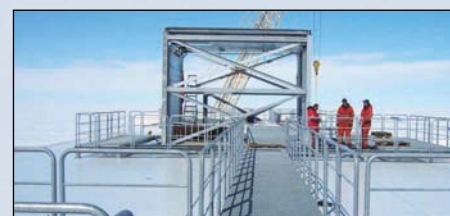
Dach der Station mit Laufgängen und Ballonfüllhalle
