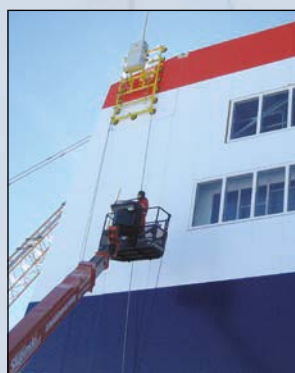
Montage des letzten Elementes
