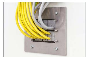
*Kanäle für Elektro- und Netzwerkinstallation können entweder in die Wand- und Deckenelemente flächenbündig eingeschäumt oder außen liegend montiert werden. Für die äußere Installation stehen luft- und staubdichte Durchführungen zur Verfügung, die sich später leicht anpassen und erweitern lassen.*
