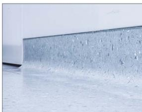
*Alle Böden sind völlig glatt und ohne Fugen verlegt. Die Fußleisten springen gegenüber den Wänden leicht zurück und gehen abgerundet und fugenlos in den Boden über.*
