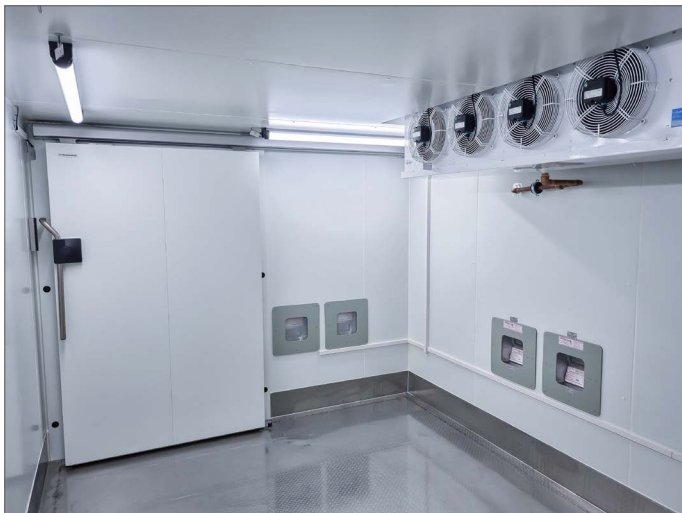
Schleuse mit aktiver -20 \text{ °C} Kühlung
