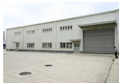
Werksgelände in China
